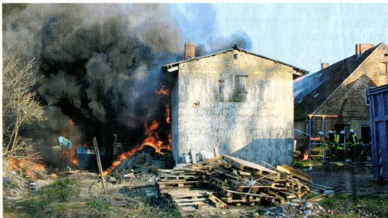
Der Stall aus der Zeit um 1900/1910 mit einem jüngeren Anbau brannte vollständig aus. Holz und Reifen lieferten dem Feuer reichlich Nahrung. Die Löscharbeiten gestalteten sich aufgrund der starken Rauchentwicklung sehr schwierig.
