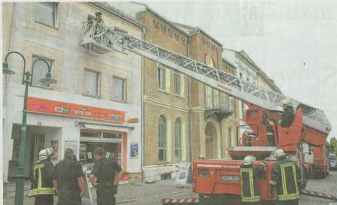
Drei angekippete Fenster, eines davon zerborsten - diese Situation fand am Dienstagnachmittag die Pasewalker Feuerwehr in der Marktstraße vor.
