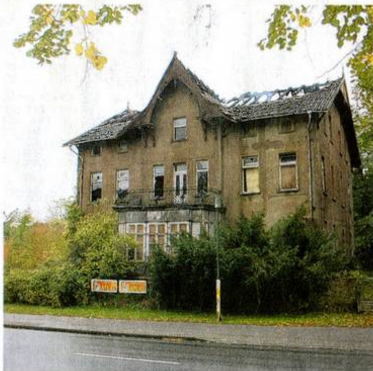
Die Dachsparren liegen nach dem Brand gestern im früheren Amtsgericht von Strasburg frei.
