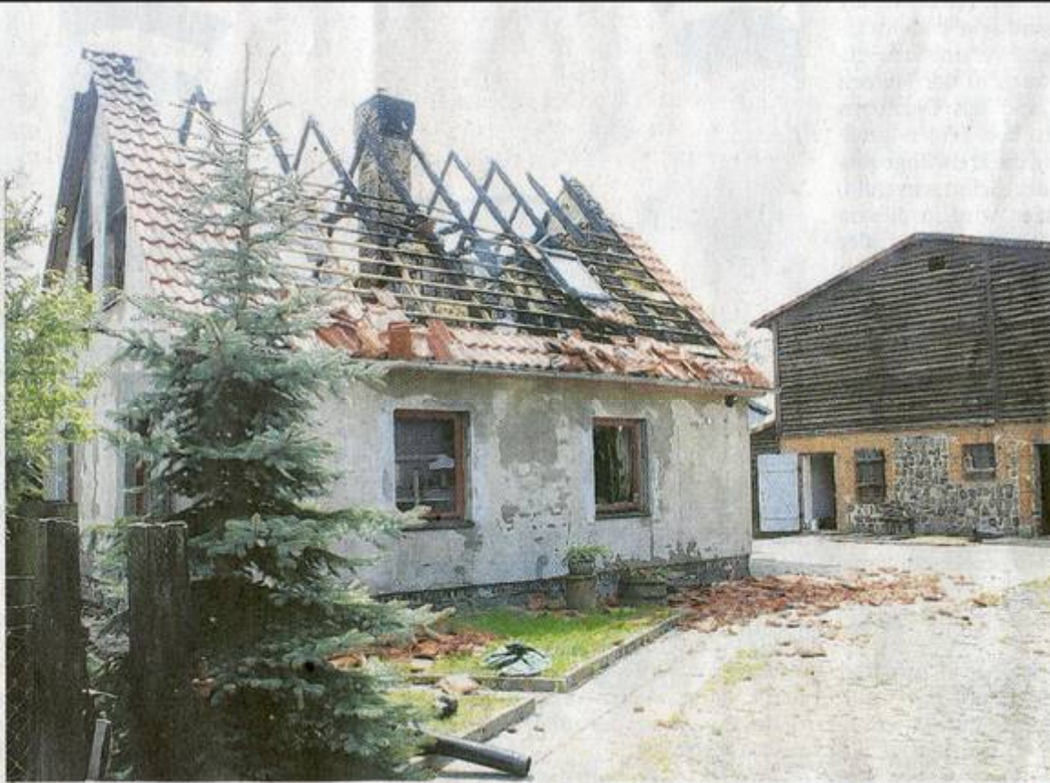
Zerstört nach einem Brand wurde in der Nacht zu Freitag dieses Wohnhaus in Gellin. Der Dachstuhl brannte völlig aus, auch im Erdgeschoss gibt es große Schäden.
