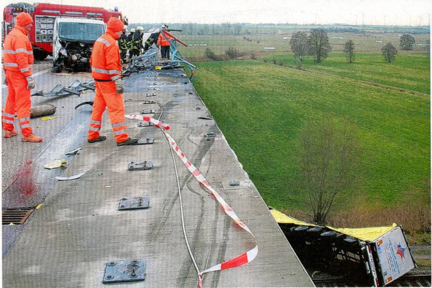
Entgegengesetzt zur Fahrtrichtung steht der zerstörte Transporter einer Neubrandenburger Firma, der Lkw aus Bulgarien liegt mit dem hinteren Teil auf einem der beiden Bahngleise zehn Meter tiefer. Die Autobahn konnte erst wieder freigegeben werden, nachdem dieser Teil der Ueckertalbrücke provisorisch gesichert wurde. Die Brückenabsperzung wurde durch den Aufprall auf etwa 20 Metern zerstört. FOTO: F. LUCIUS
