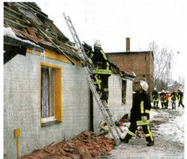
Die Sommersdorfer Kameraden mussten gestern nochmal 'ran: Qualm stieg erneut aus dem Dachstuhl empor.
