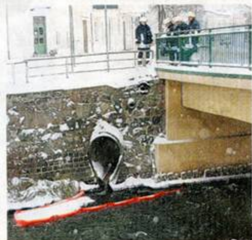
Direkt an der Ueckerbrücke richtete gestern die Feuerwehr eine Ölsperre ein.
